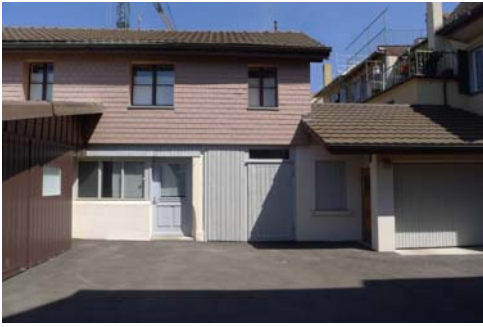
0274 Nebengebäude an der Rückseite
