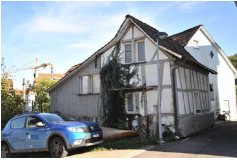
1419 Nebengebäude, Nord- und Westfassade
